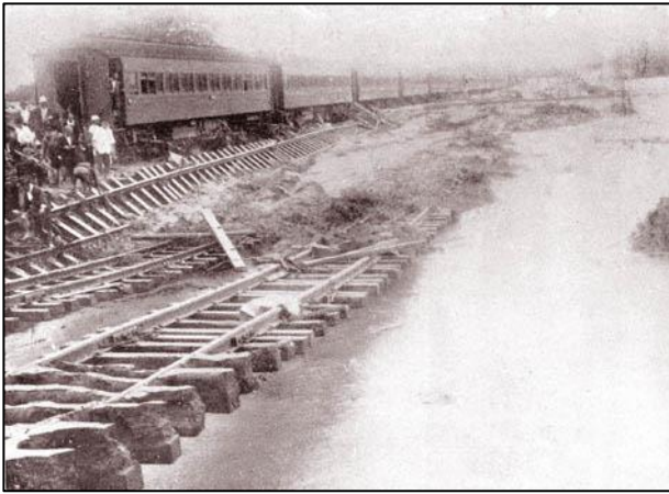
本山第二小学校南側 国鉄省線電車線路の流失
