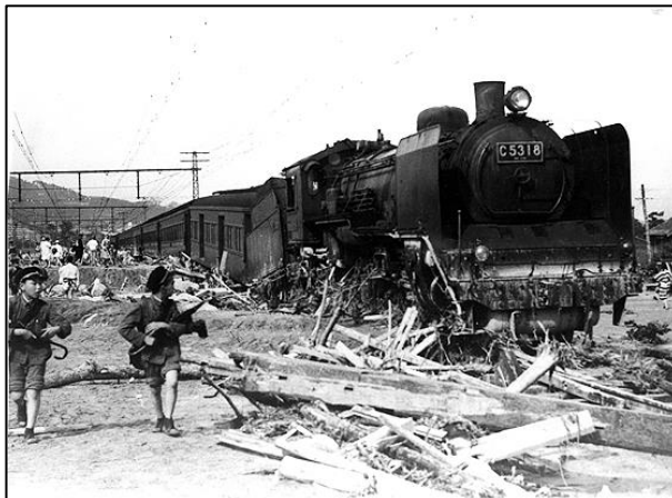
阪神大水害・東海道本線の線路も埋没 (神戸市 摂津本山、住吉間)
