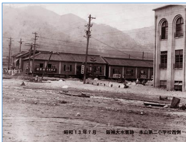
本山第二小学校西側 丸穴の塀が埋もれている
