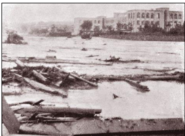
本山第二小学校～現本山中学校グラウンド付近
