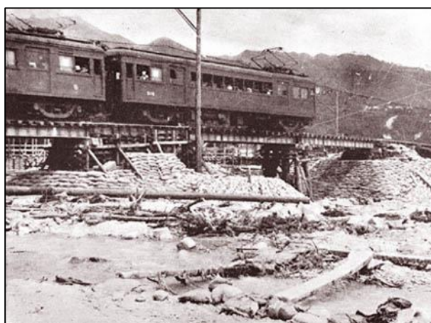
仮設鉄橋で通過する阪急電車
