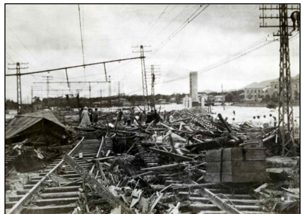
国鉄東海道線摂津本山駅西方の線路は、住吉川などの氾濫で流されてきた家のがれきで埋まった。架線柱も激しい水流で傾いている
