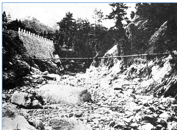
水道仮設送水線（住吉村 浄水場ポンプ室前）
