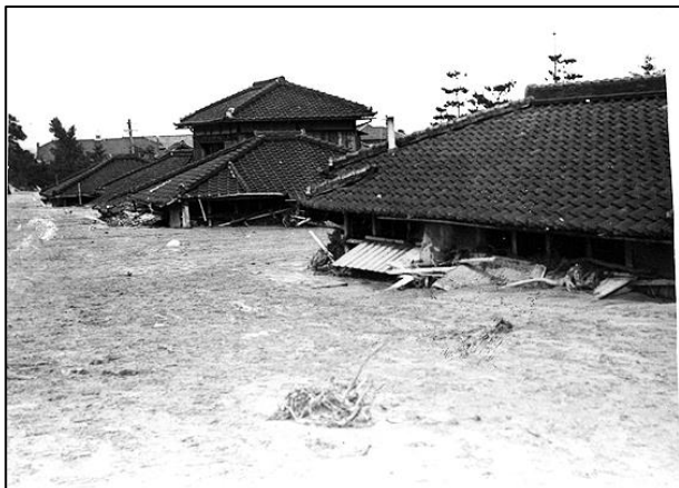
阪神大水害・泥に埋もれた神戸の住宅 (神戸市東灘区本山)
