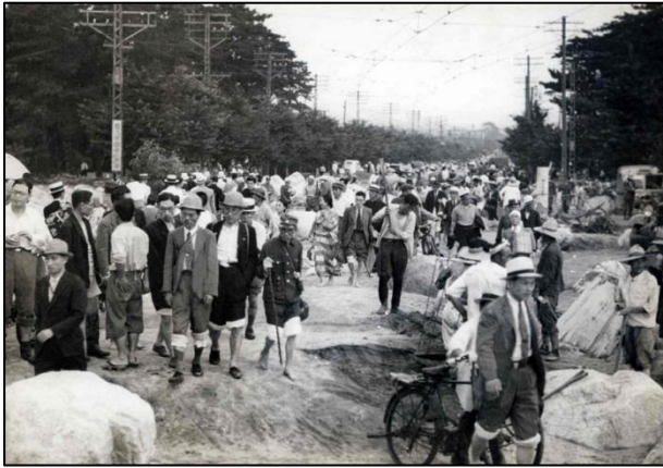
水害の救援と見舞いの人々で混雑する阪神国道（国道2号）の住吉川橋付近。住吉川が氾濫、六甲山から押し流されてきた巨岩で国道は埋め尽くされている
