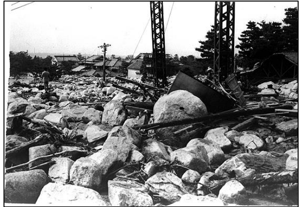
阪神大水害・阪急沿線御影、 岡本間の落石(神戸市東灘区御影付近)
