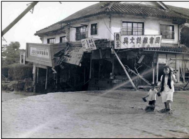
住吉川が氾濫、阪神国道（国道2号線）を流れる濁流。国道沿いの商店も1階が破壊された
